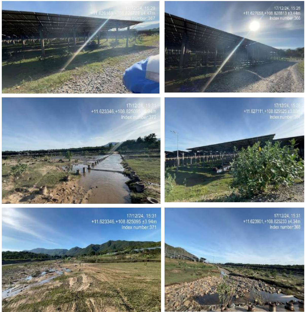
Hình 3.3: Nước mưa thấm theo theo địa hình tự nhiên khu pin mặt trời
