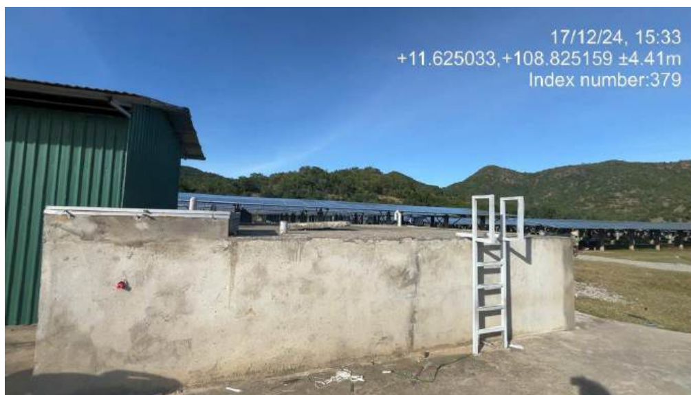
Hình 3.10: Hệ thống máy lọc xử lý nước của Cơ sở
