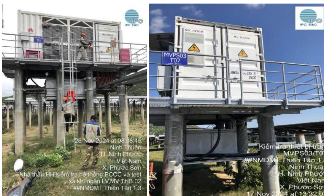
Hình 3.17: Bể thu dầu trạm Inverter
