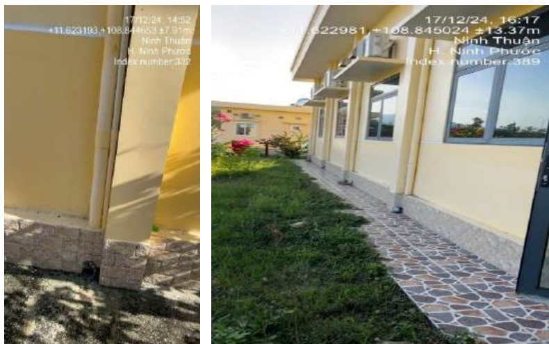
Hình 3.1: Đường ống thu gom nước mưa từ mái nhà
